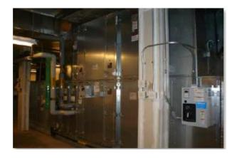
I sistemi di depurazione dell'aria Dynamic non solo hanno contribuito a ridurre la potenza dei ventilatori e risparmiare energia, ma i filtri dell'aria essendo più piccoli hanno un ingombro molto più ridotto e intervalli di manutenzione più lunghi rispetto agli equivalenti filtri passivi convenzionali.
